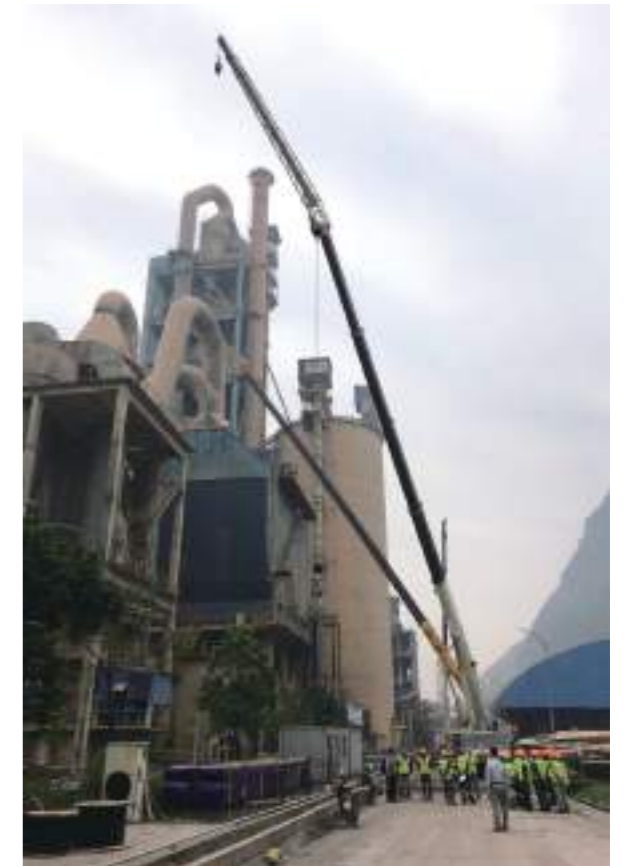
베트남 롱푸 화력발전소의 탈황 설비 공사 현장.
