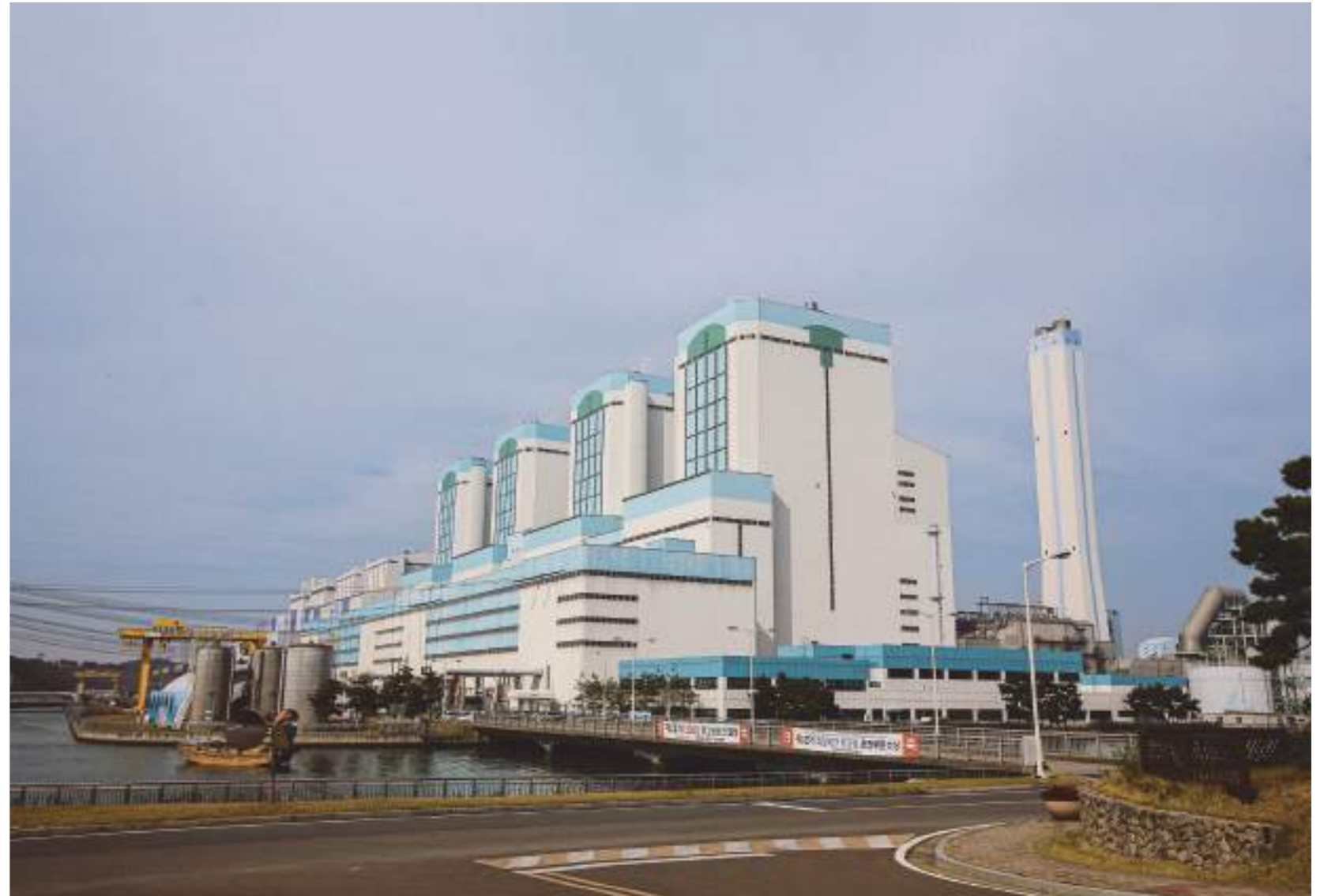
한국코트렐이 1990년대 중반 독일 스타인뮐러 사로부터 탈황 기술을 도입하고 최초로 시공한 당진화력발전소.
